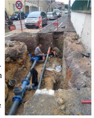
L'intégralité des branchements d'eau de cette section a été remplacée, permettant ainsi la suppression des nombreuses canalisations en plomb qui subsistaient jusqu'alors. Les derniers éléments de marquage et de mobilier extérieur seront posés dans les semaines à venir. Nous remercions les commerçants et riverains pour leur patience durant ces multiples, mais inévitables, mois de travaux.
